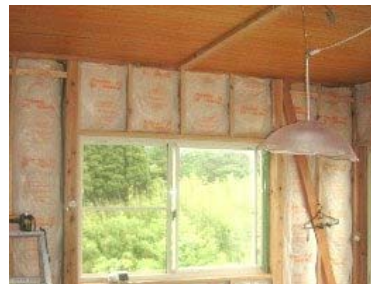
2階和室の天井貼り
