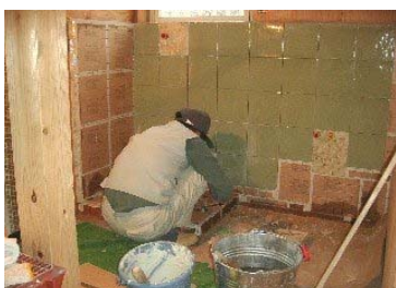
洗濯場もタイルで工事
