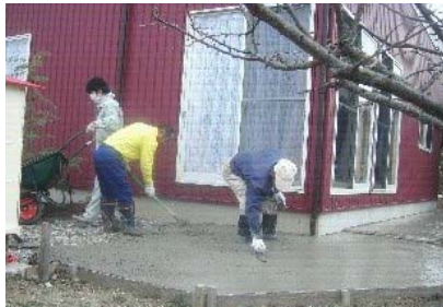
コンクリート打ち工事中
