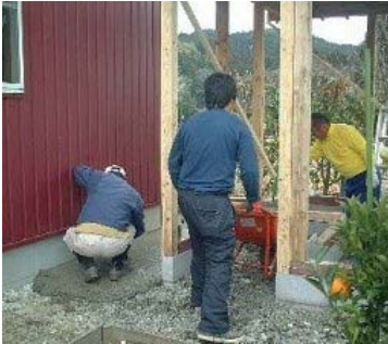
コンクリート打ち開始
