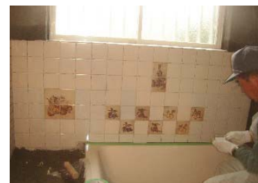
風呂タイル工事中
