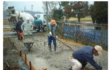
雨の中駐車場コンクリート打ち
