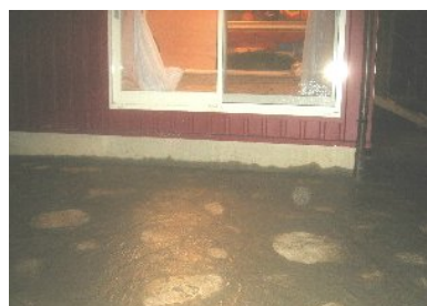
夜半まで工事が続く
