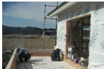
広いベランダの工事も開始
