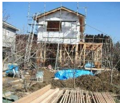
屋根の工事中
