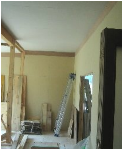
石膏ボード貼り作業
